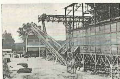
Fig. 11. Silo- og blandedanlæg. Bemærk mændenes størrelse i baggrunden (Camus).
